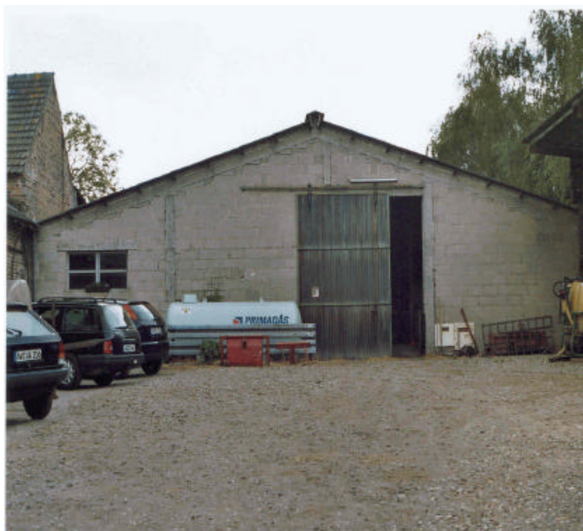
Bild 2: Ansicht vom Beispiel Weg aus, Ostseite
